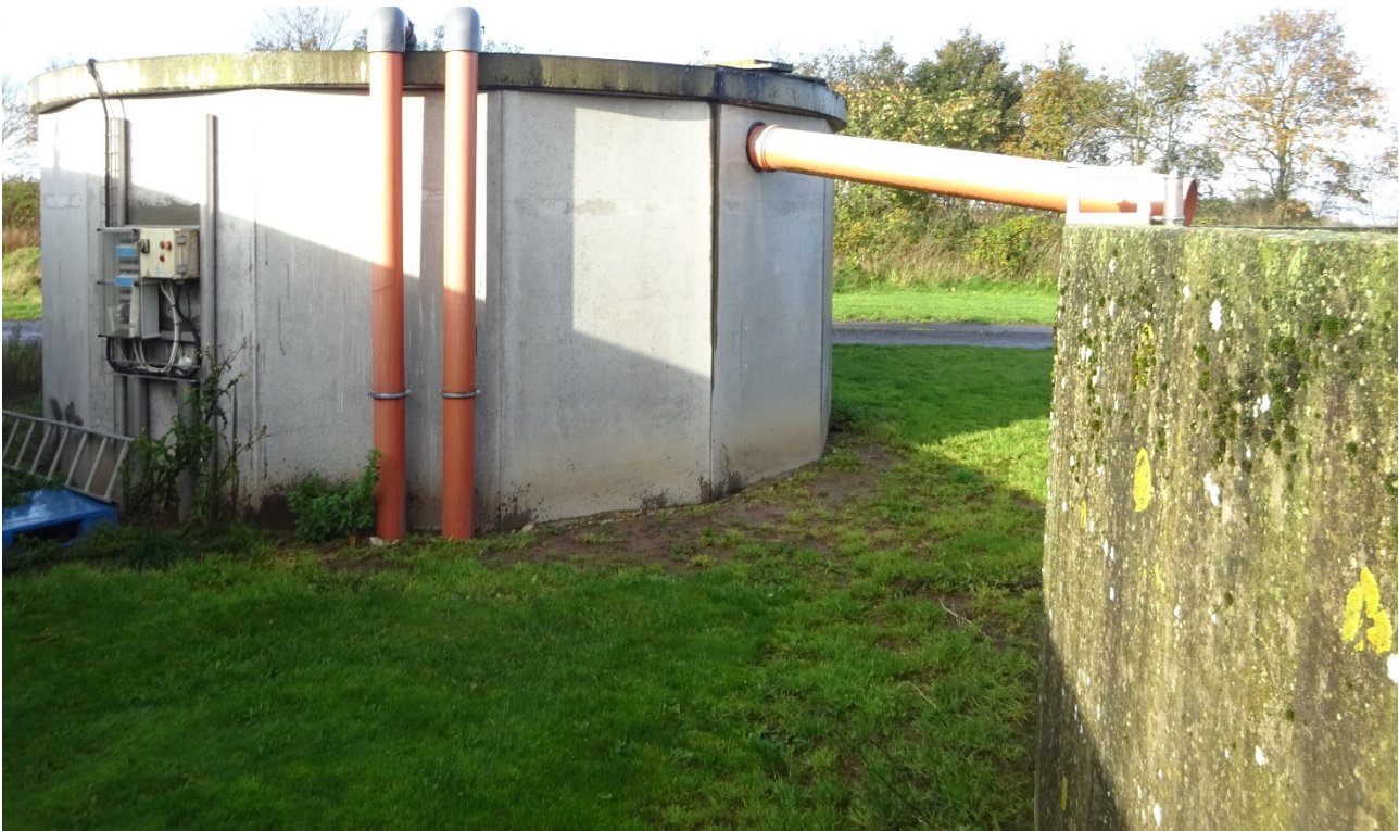
Figur 36: Afhentningstank med overløb til lagertank.
