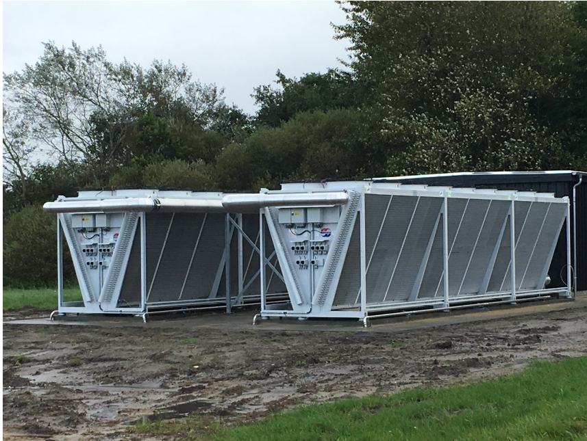
Figur 8.7 – Billede af luftkølerne i Sig.
