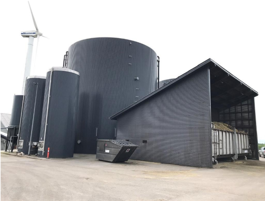
Figur 19 Rybjerg Biogas med indfødningsanlæg til fast biomasse samt de to parallelforbundne reaktorer i baggrunden.
