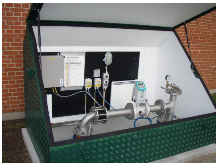
Figur 5.10 Råvandsstation garniture og frekvensomformer (venligst udlånt af brøndborer Brøker)
