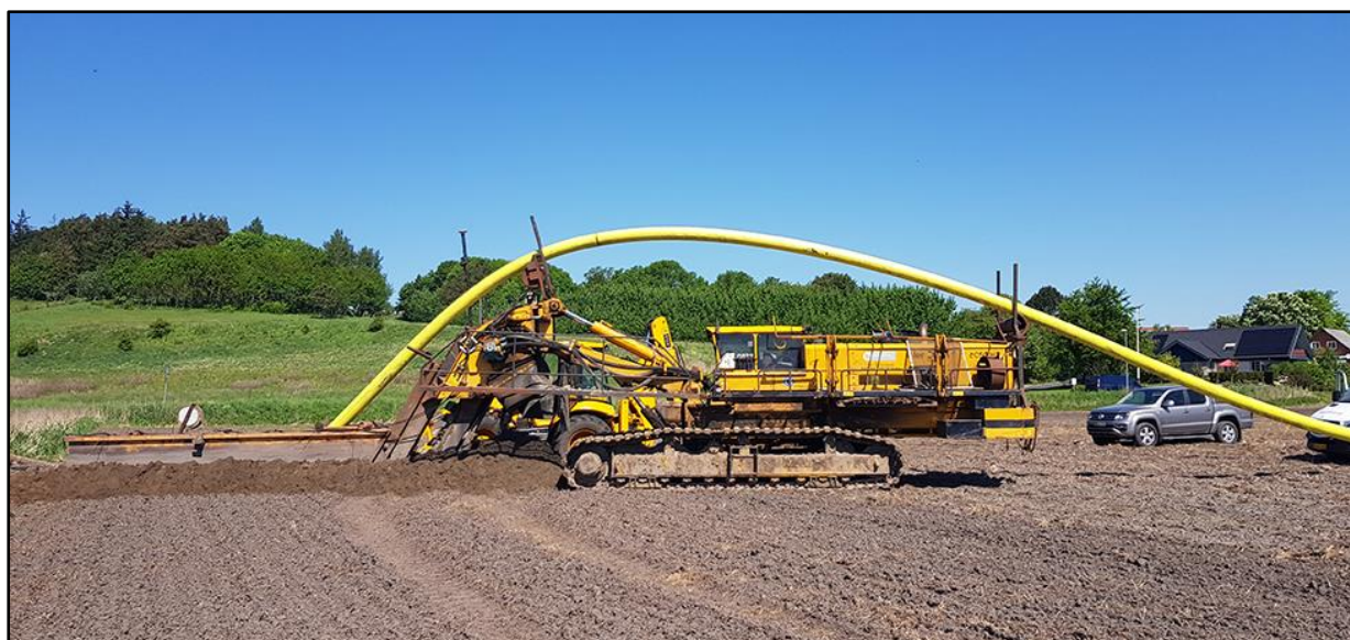
Figur 5.8. Nedgravning af drænrør. (foto venligst udlånt af SM Entreprenør)
