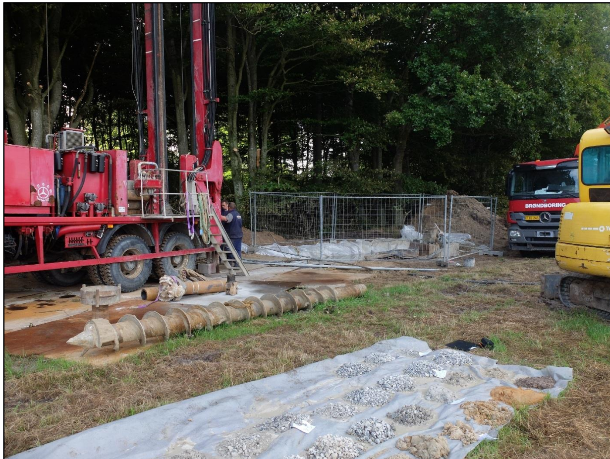
Figur4.13 Mobil borerig med lufthæveteknik til dybe borerig. Læg mærke til jordprøverne på fiberdugen nederst i billedet. (Foto venligst udlånt af brøndborerfirmaet Søren Pedersen)
