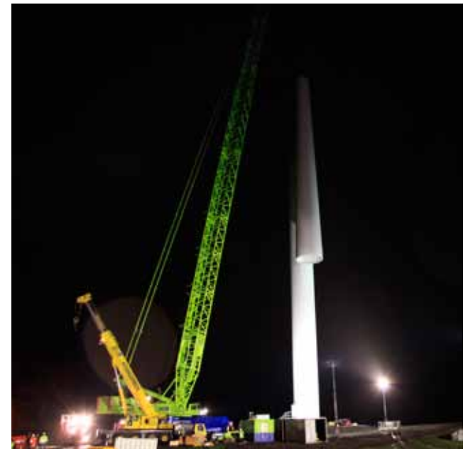
Foto 3.2 Kranarbejde ved opstilling af vindmølletårn. Foto: Uhre Windpower I/S.
