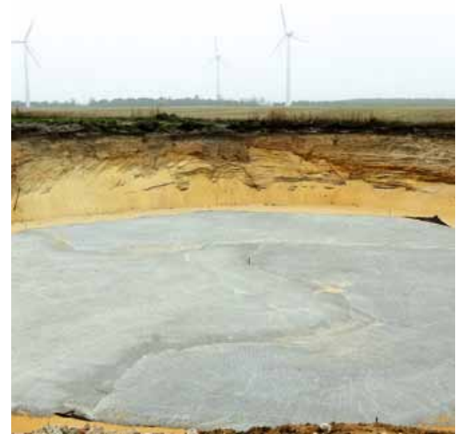
Foto 3.2 Støbning af pladefundament.
