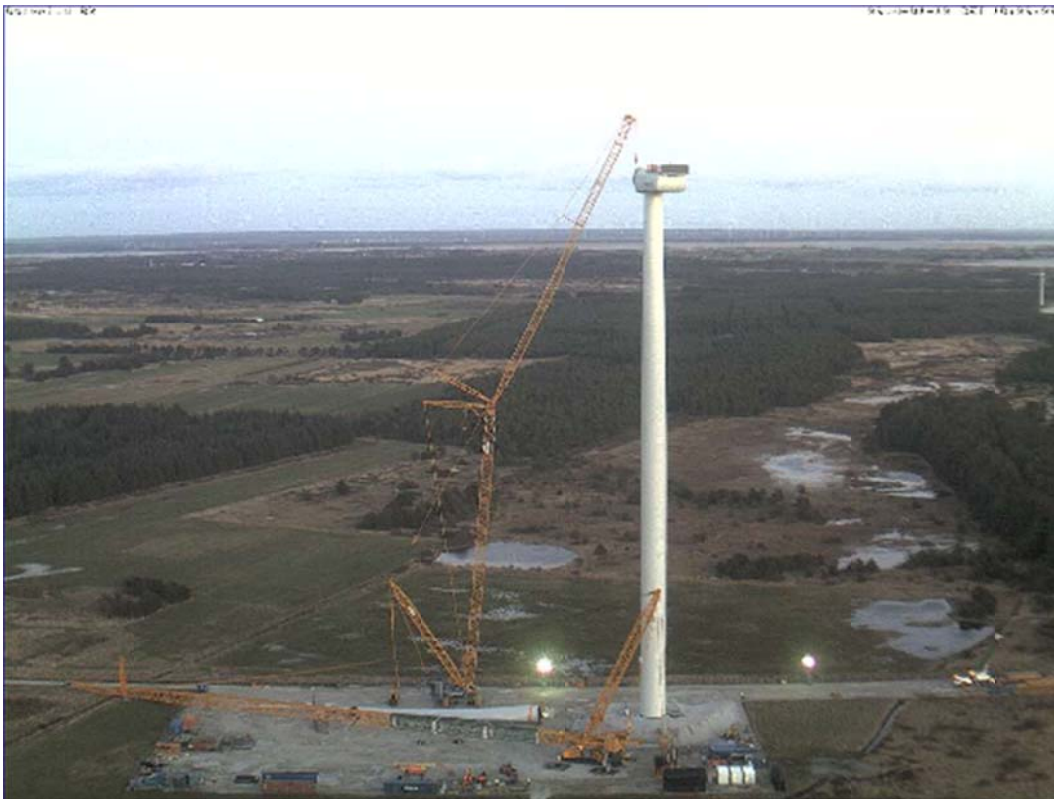
Figur 5.21: Opstilling af V164 ved Østerild, hvor den ene kran er lagt ned. Foto: Vestas.
