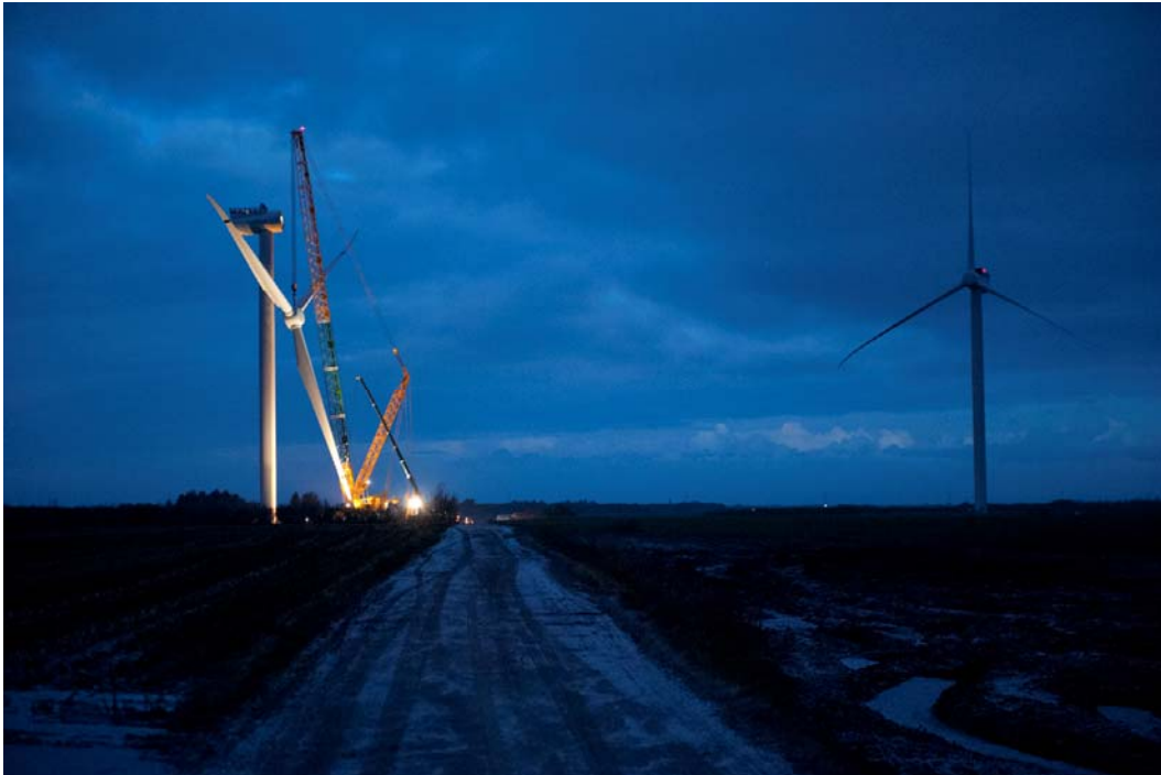
Figur 9.2a: Oplyst byggeplads ved hejsning af 120 meter rotor en vintermorgen ved Tim nord for Ringkøbing.
