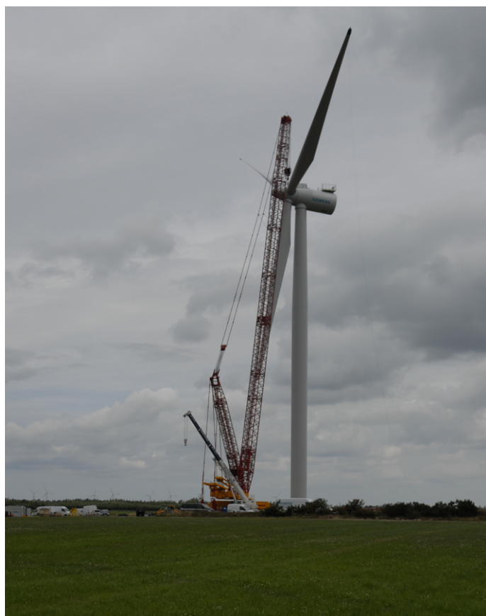
Foto 1. I juli rejstes en 143,5 m høj vindmølle ved Tim i Vestjylland, som er uden gear. Dermed vil den støje langt mindre end de traditionelle vindmøller. Udviklingen vil formentlig give flere vindmøller med samme teknik.
