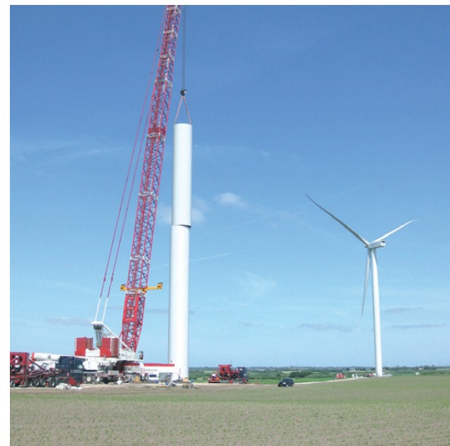
Foto 3.3 - Kranarbejde ved opstilling af vindmølletårn.
