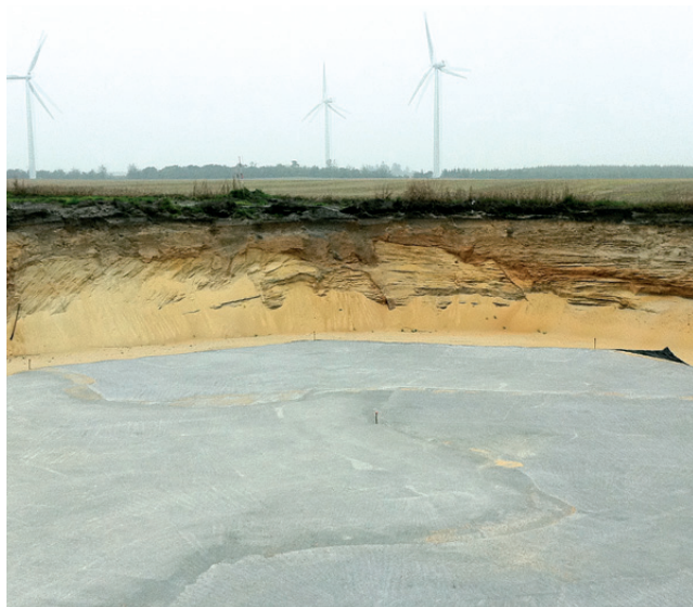
Foto 3.2 Støbning af pladefundament.
