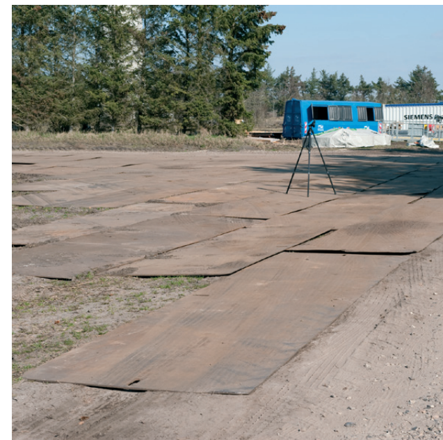
Foto 3.1 Sving på arbejdsvej af jernplader.
