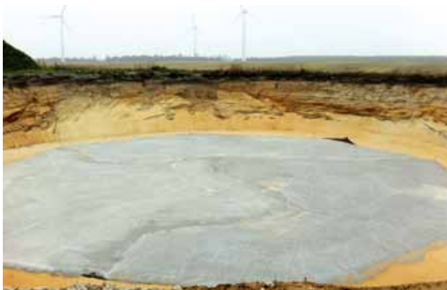
Foto 3.2 Støbing og etablering af fundament.
