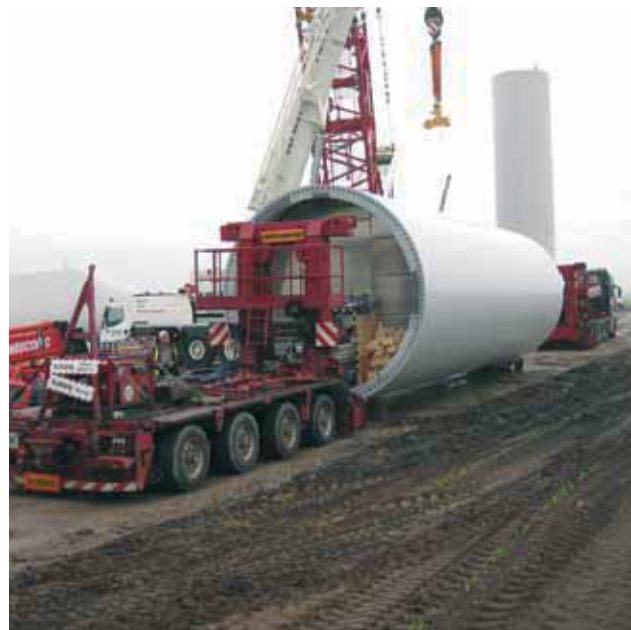
Foto 3.1 - Transport af tårnsektioner.
