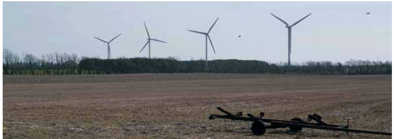
Foto 4.5 Fire eksisterende vindmøller ved Mejerivej øst for Hejnsvig
