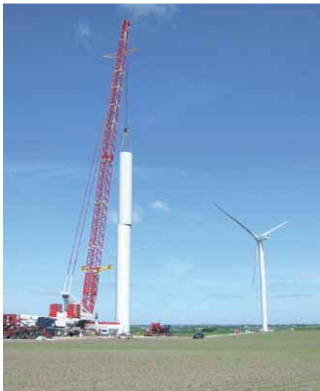
Foto 2.1 Kranarbejde ved opstilling af vindmølletårn.
