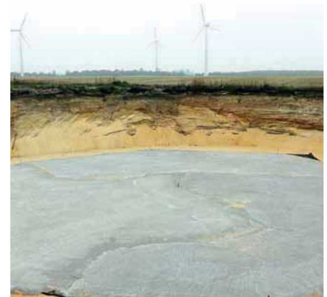
Foto 3.2 - Støbning og etablering af fundament.
