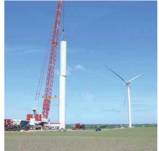
Foto 3.3 - Kranarbejde ved opstilling af vindmøllertårn.
