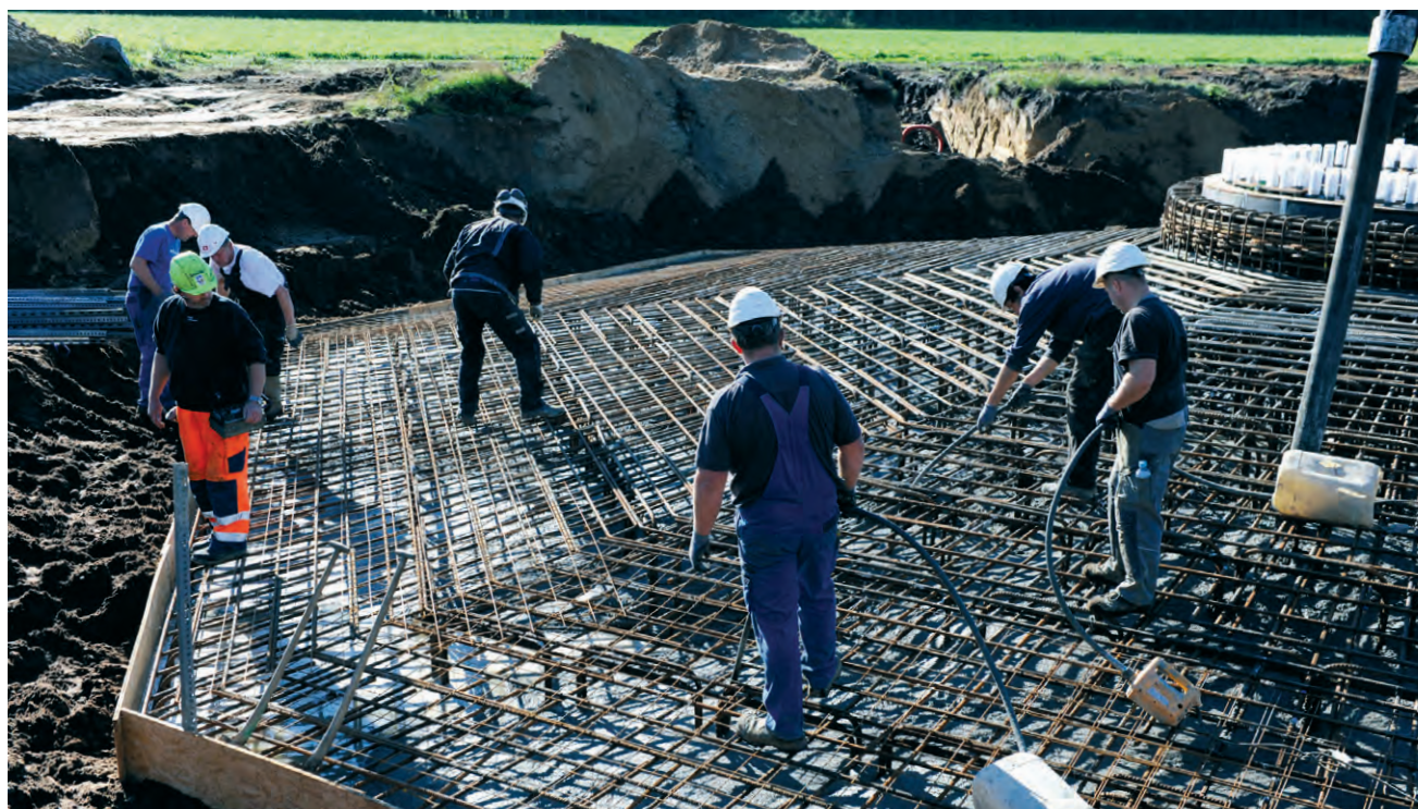
Foto 3.2 Støbning af pladefundament
