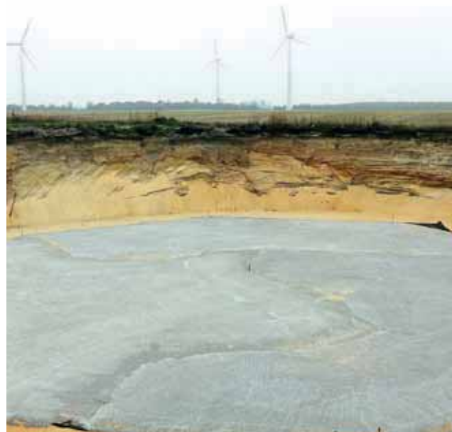
Foto 3.2 - Støbning af fundament.
