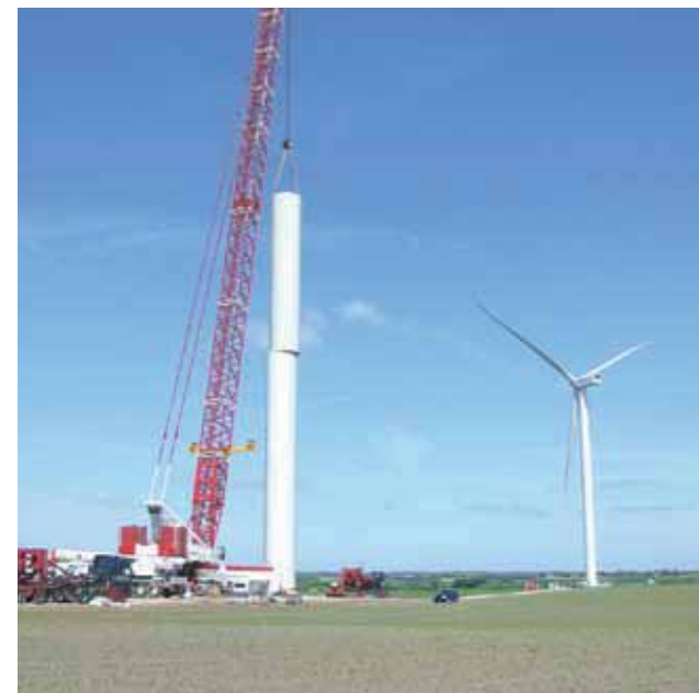
Foto 3.3 - Kranarbejde ved opstilling af vindmølle-tårn.
