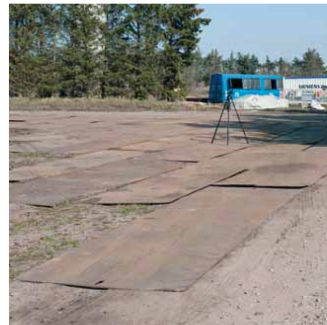
Foto 3.1 Sving på arbejdsvej af jernplader.
