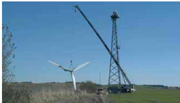
Foto 2.1 Nedtagning af ældre vindmølle
