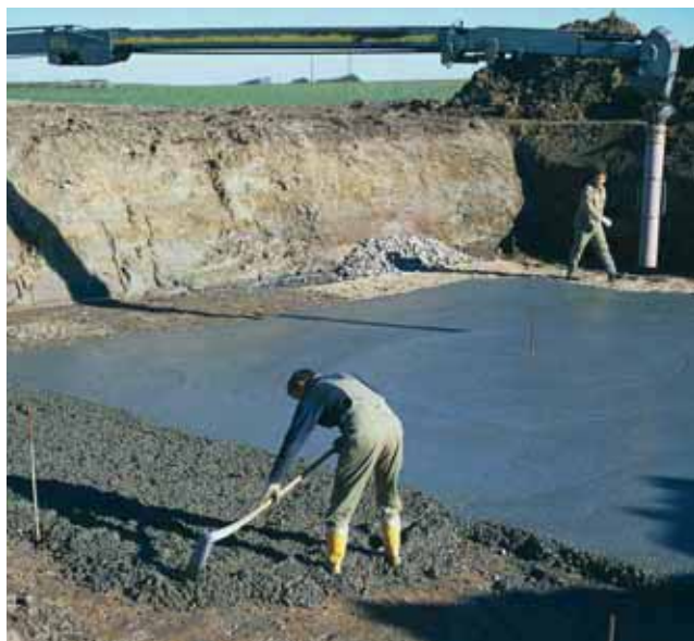
Foto 3.1 Støbning og etablering af fundament.
