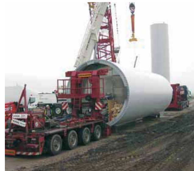
Foto 3.2 Transport af tårnsektioner.
