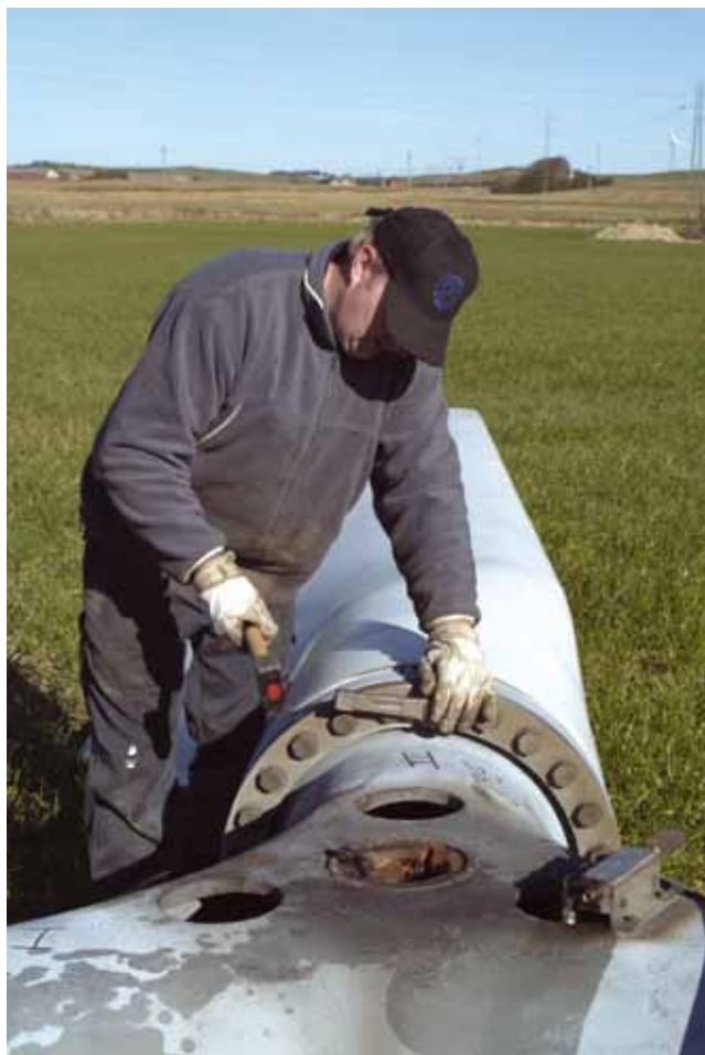
Foto 3.2 Demontering til genbrug.
