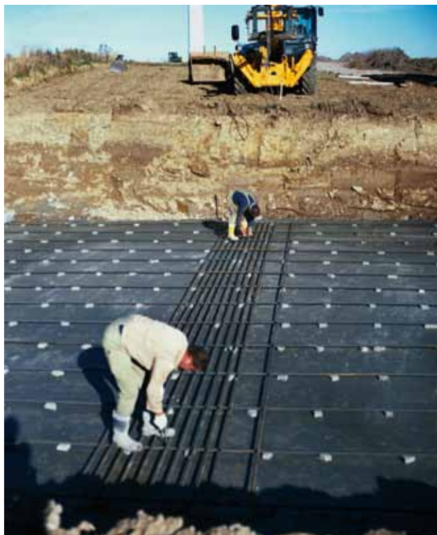
Foto 2.2 Jerngitter bliver bundet i fundament.
