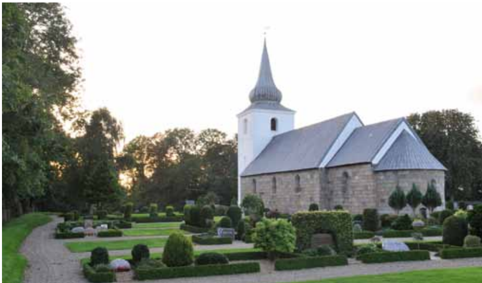
Foto 4.8 Vejrum Kirke er fra det 12. århundrede og opført af kampestenskvadre og tækket med blytag. Tårnet er fra sengotisk tid. I 1736 fik Chr. Moth til Quistrup opført et firsidet spir, der senere i slutningen af 1700-tallet blev afløst af den nuværende løgkuppel.
