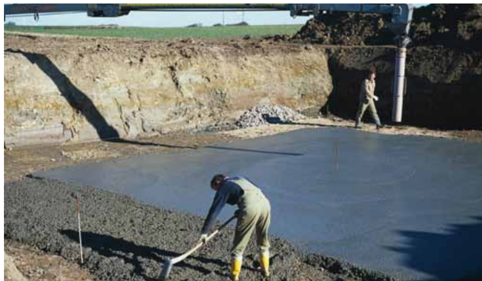
Foto 3.1 Anlæg af fundament til 2 MW-mølle.
