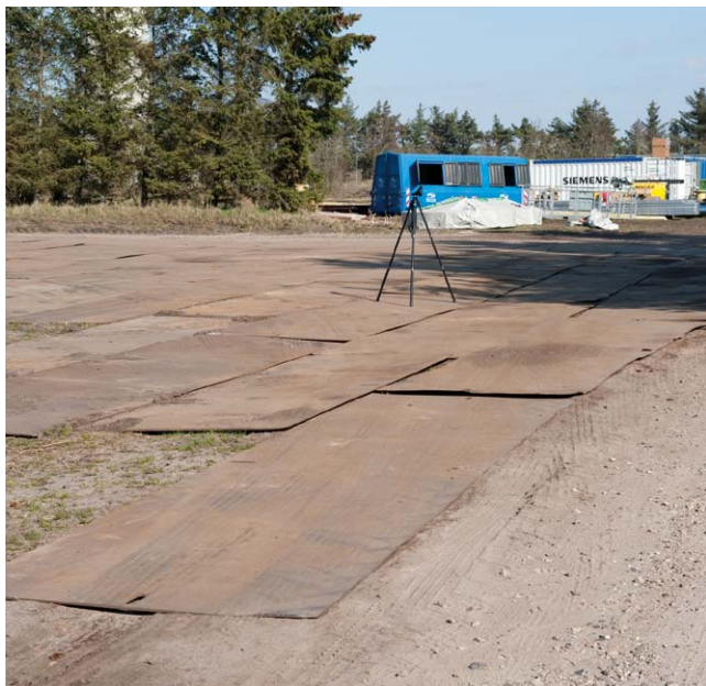
Foto 3.1 Sving på arbejdsvej af jernplader.
