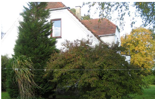
Foto 5.1 Nabobolig 1, St. Røttingevej 5, fra haven mod nord.
