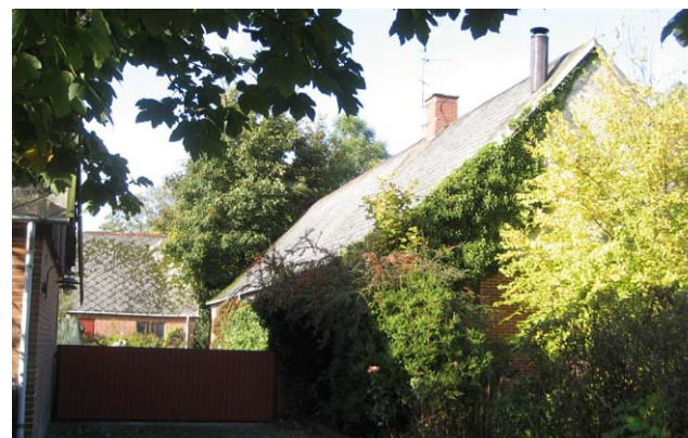
Foto 5.11 Nabobolig 11 fotograferet fra St. Røttingevej mod vest,
