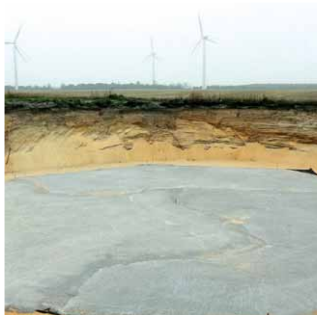
Foto 3.2 - Støbing og etablering af fundament.
