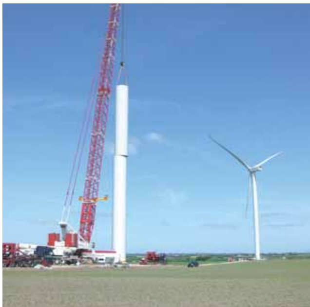
Foto 3.4 - Kranarbejde ved opstilling af vindmøllertårn.
