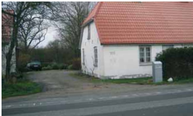
Foto 5.12, nabobolig 13, Koldingvej 165, fotograferet fra Koldingvej mod nordvest.
