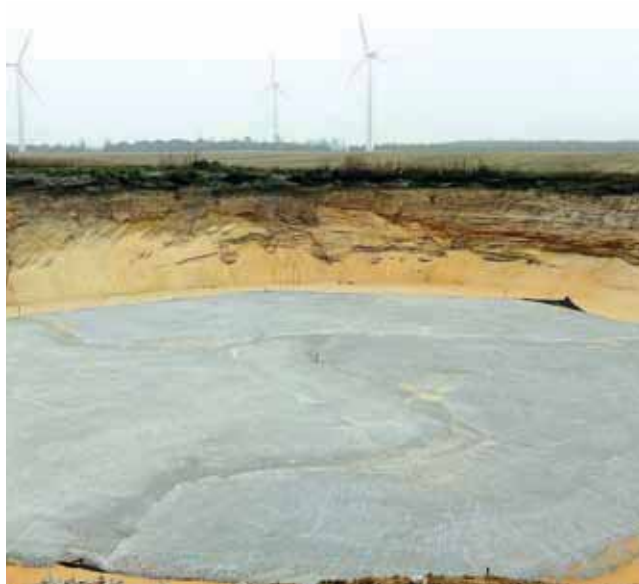
Foto 3.2 Støbning og etablering af fundament.
