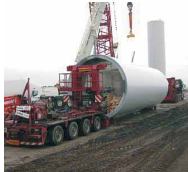
Foto 3.3 Transport af tårnsektioner.
