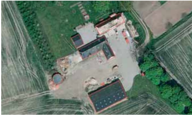
Luftfoto 5.13, nabobolig 16, Ødisvej 36.
