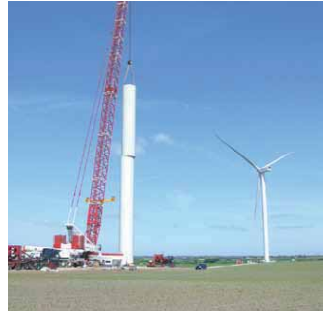
Foto 3.4 Kranarbejde ved opstilling af vindmølletårn.
