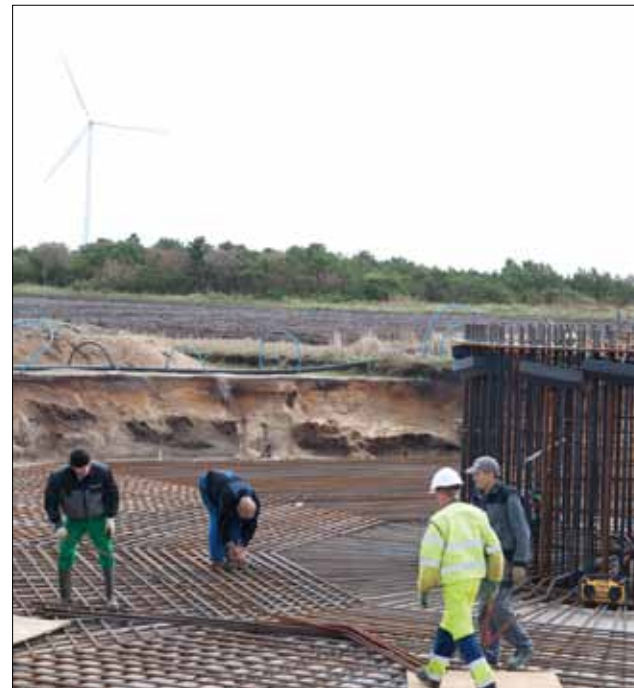
Foto 3.3 Binding af fundament.
