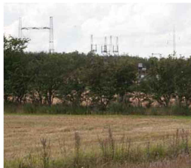
Foto 4.2 60 kV eltracé og transformerstation syd for Ejstrupholm.
