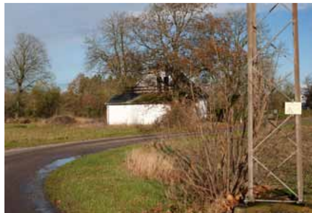
Foto 5.13 Nabobolig 11, Brandevej 54, fotograferet fra syd.
