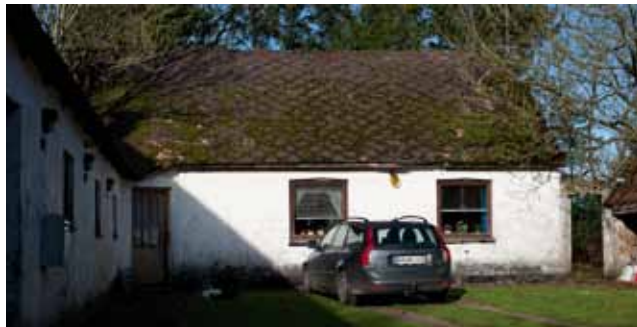
Foto 5.11 Nabobolig 9, Brandevej 60, fotograferet fra syd.
