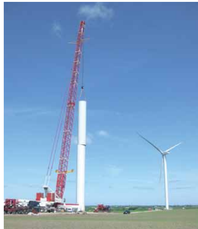
Foto 3.5 - Kranarbejde ved opstilling af vindmøllertårn.
