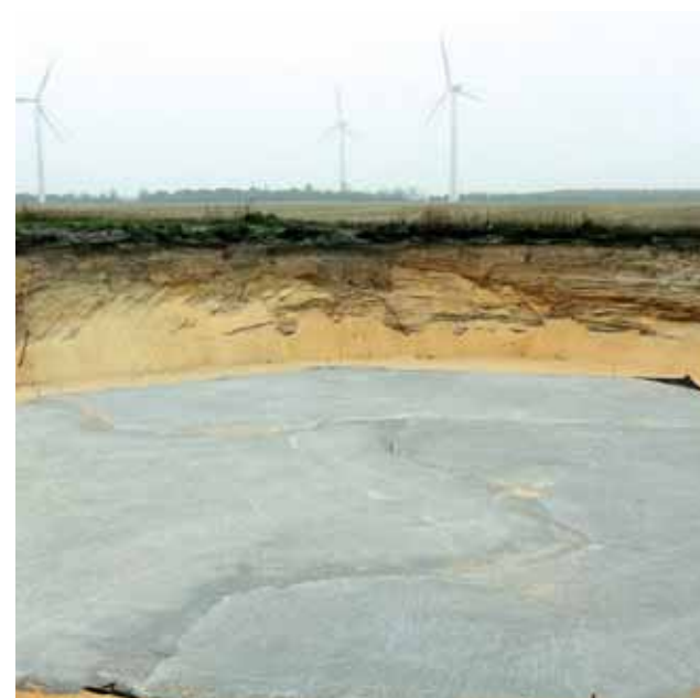
Foto 3.2 - Fundament for tildækning med jord.
