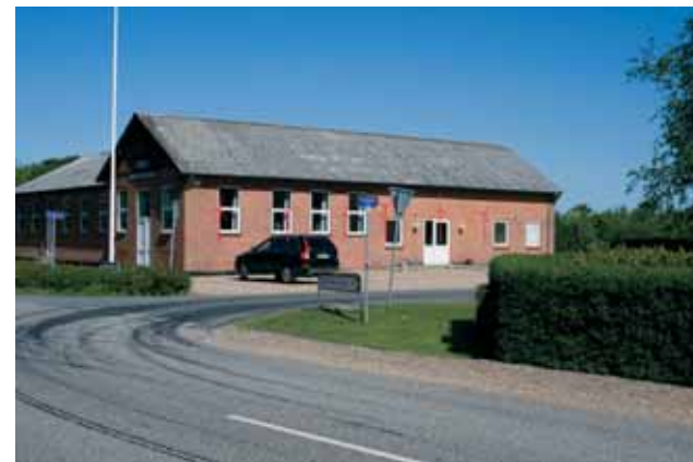
Foto 4.10 Visualisering fra Ølgodvej i Urup. Vindmøllerne er markeret med rødt og vil ikke påvirke oplevelsen af Urup Forsamlingshus.
