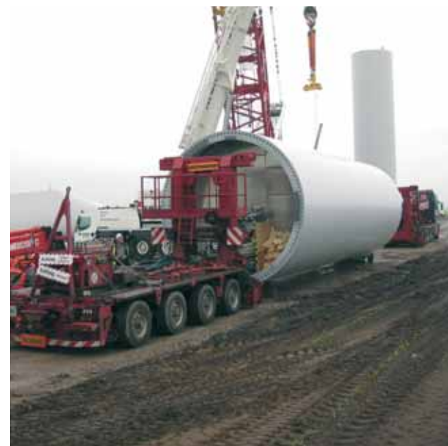
Foto 3.1 - Transport af tårnsektioner.
