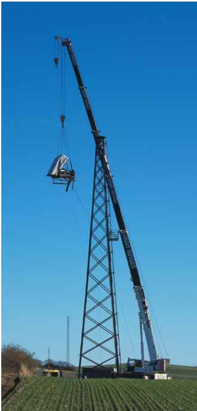
Foto 2.1 Ældre mølle under nedtagning. Møllehuset, nacellen, bliver hejst ned.
