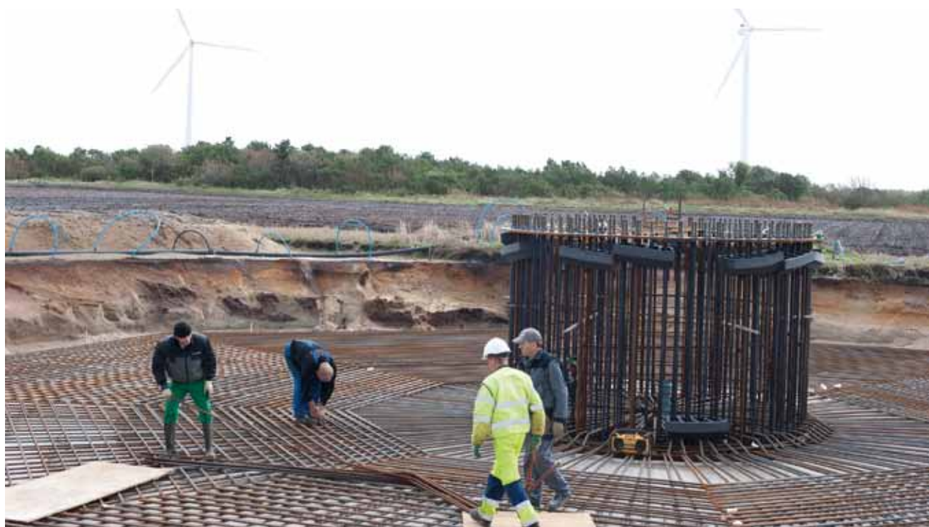
Foto 3.1 Binding af fundament til Vestas V112. Vindmøller ved Bækmarksbro Sydvest, Lemvig Kommune.
