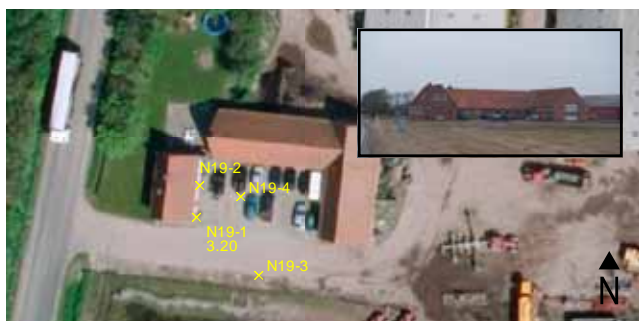
Nabobolig 18, Bøvlingvej 50. Facadefoto er taget fra sydvest.
