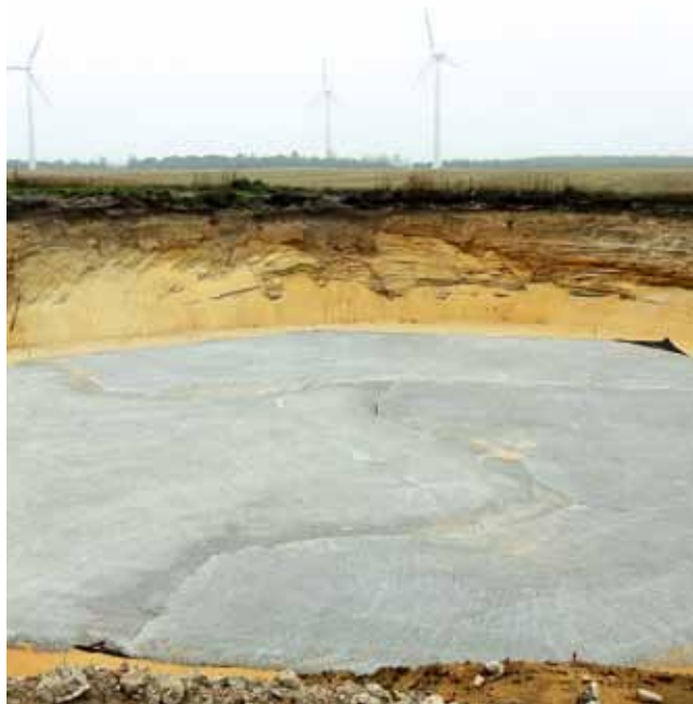
Foto 3.2 Støbing af fundament til Vestas V112. Vindmøller ved Bækmarksbro Sydvest, Lemvig Kommune.
