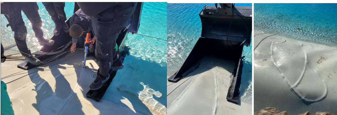
Figur 19: Reparation af revne ved hjælp af sænkekasse.
