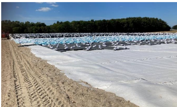
Opbygning af låg fra den østlige ende
