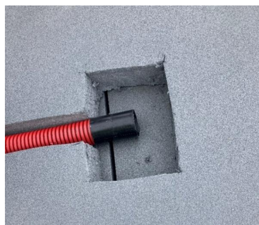
Udskæring i isolering for fugtighedsensor af typen HygroS-
